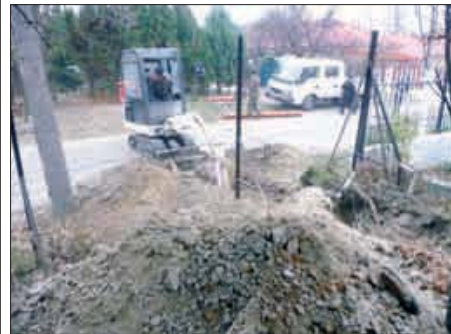
Markológéppel mélyítik az árkot a kerítés tövében
