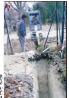
Már csak a csöveket kell elhelyezni
