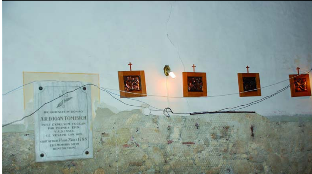
Jól láthatók az oltár fölötti repedések
